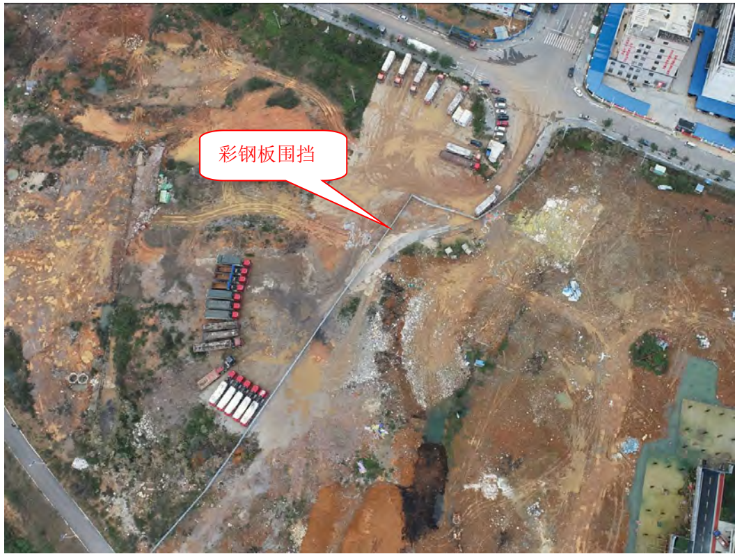
图 3.4-2 现场彩钢板围挡航拍图
